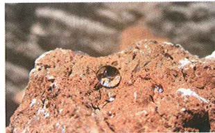
Hydrophobierung und Witterungsschutz mittels NP auf antiker Bausubstanz
